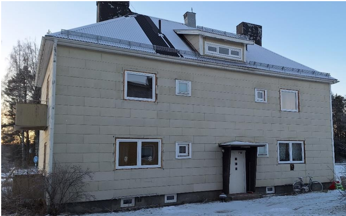
Albyvägen 8 C, fasad mot norr. Entrédörren och 5 fönster (2 i nedre plan, 2 i övre plan och takkupan) är utbytta så att de inte har samma utformning som tidigare.
