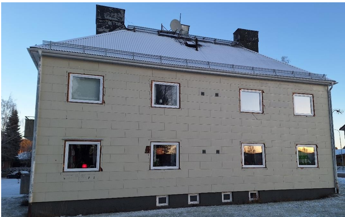
Albyvägen 8 C, fasad mot söder. 8 fönster (4 i nedre plan och 4 i övre plan) är utbytta så att de inte har samma utformning som tidigare.
