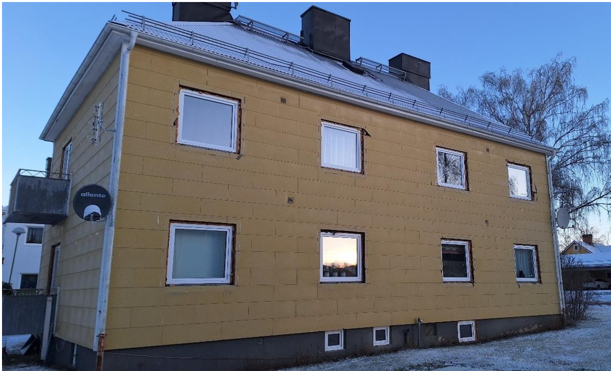
Albyvägen 8 B, fasad mot söder. 8 fönster (4 i nedre plan och 4 i övre plan) är utbytta så att de inte har samma utformning som tidigare.
