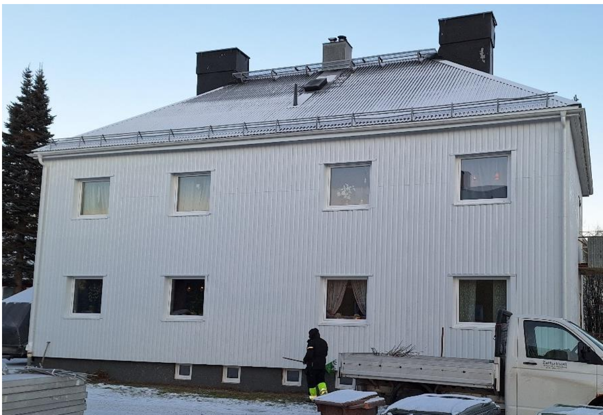
Albyvägen 8 A, fasad mot söder. Fasadmaterialet är bytt från ljusgråa eternitplattor till vit plåt. Fasadyta: 6,1 \times 15,5 \text{ m} = 94,5 \text{ kvm} . 8 fönster (4 i nedre plan och 4 i övre plan) är utbytta så att de inte har samma utformning som tidigare.
