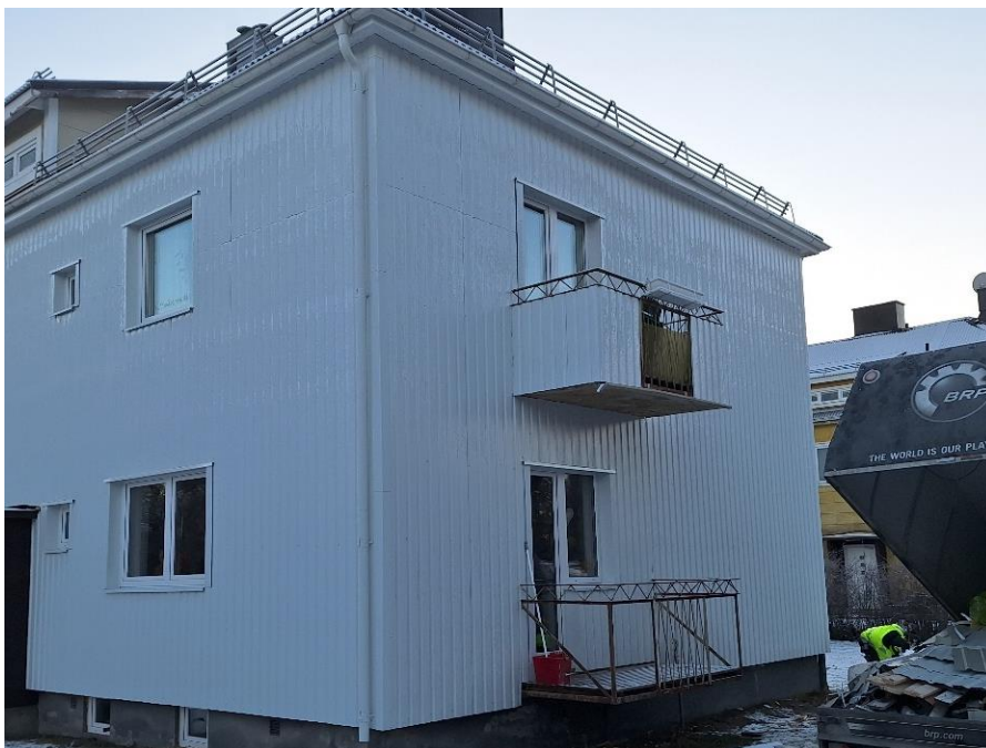
Albyvägen 8 A, fasad mot väster. Fasadmaterialet är bytt från ljusgråa eternitplattor till vit plåt. Fasadyta: 6,1 \times 8,5 \text{ m} = 51,8 \text{ kvm} . 2 balkongdörrar och 2 fönster är utbytta men har ungefär samma utformning som tidigare.
