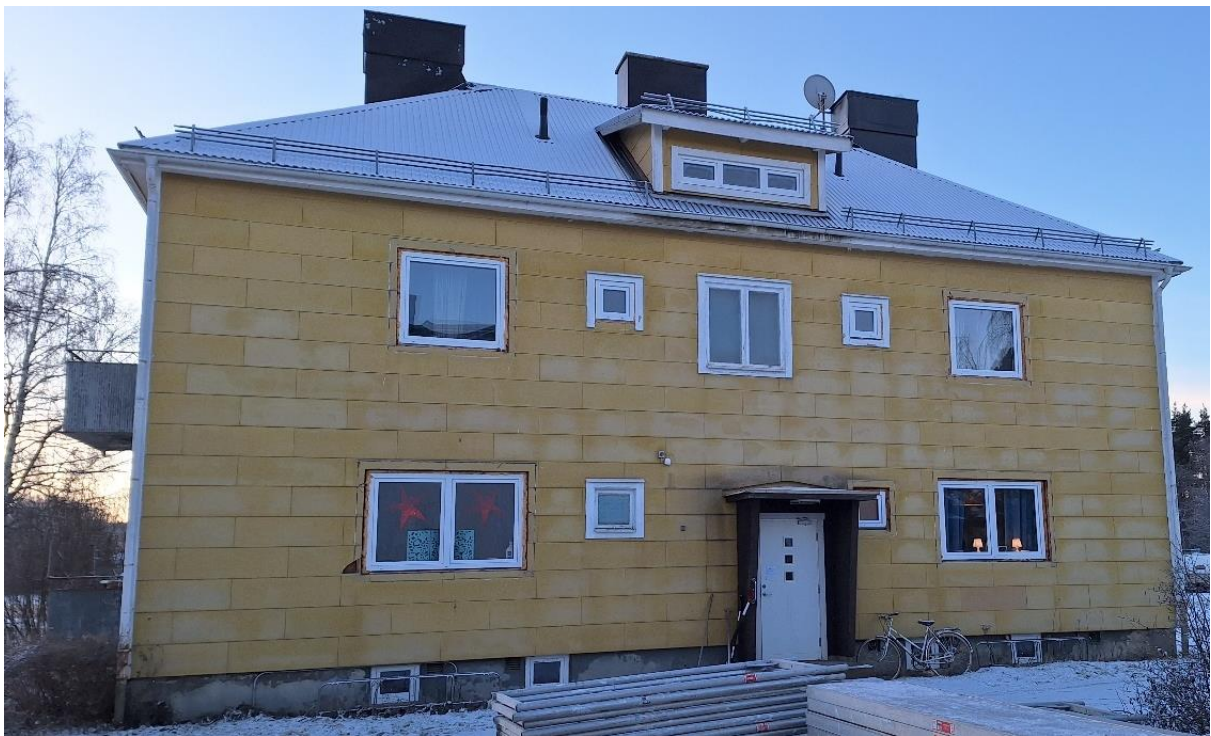
Albyvägen 8 B, fasad mot norr. Entrédörren och 5 fönster (2 i nedre plan, 2 i övre plan och takkupan) är utbytta så att de inte har samma utformning som tidigare.
